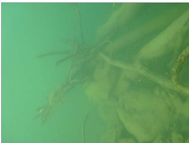
Uferpark Luterbach Entfernen der Baumstämme 2022/03/27
