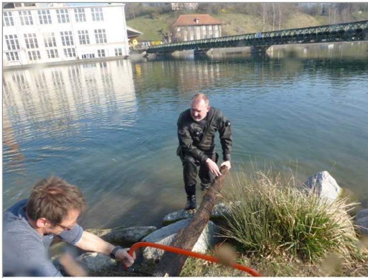
Uferpark Luterbach Entfernen der Baumstämme 2022/03/27
