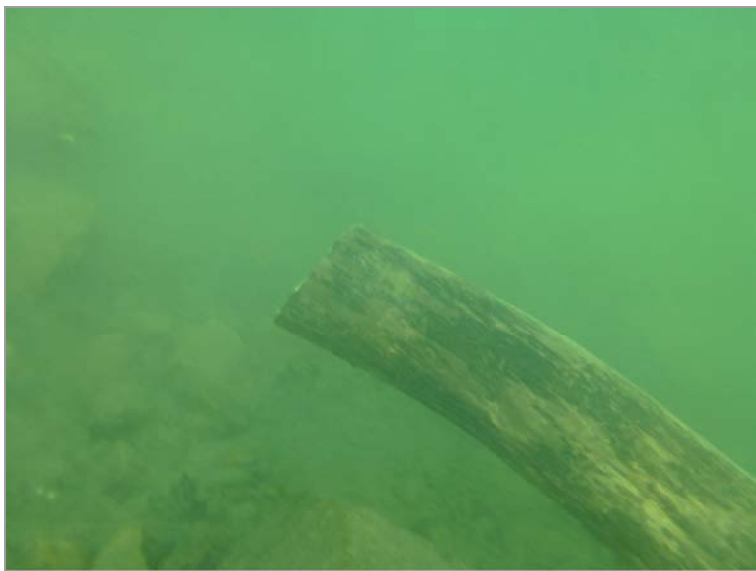
Uferpark Luterbach Entfernen der Baumstämme 2022/03/27
