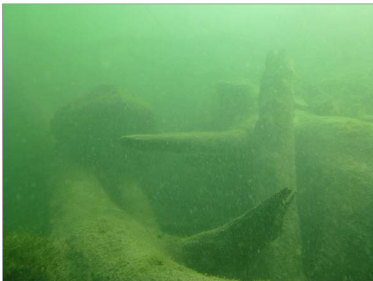
Uferpark Luterbach Entfernen der Baumstämme 2022/03/27
