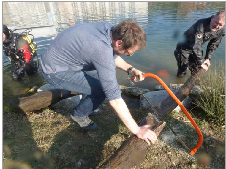
Uferpark Luterbach Entfernen der Baumstämme 2022/03/27
