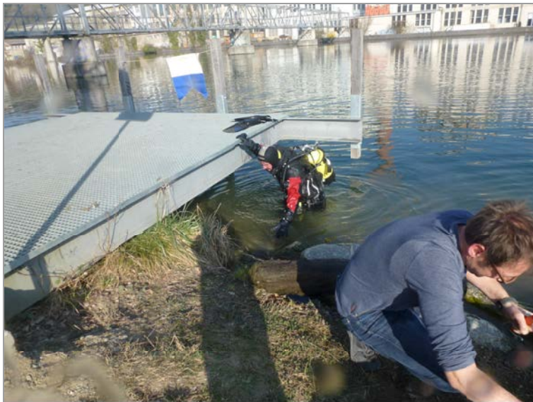
Uferpark Luterbach Entfernen der Baumstämme 2022/03/27
