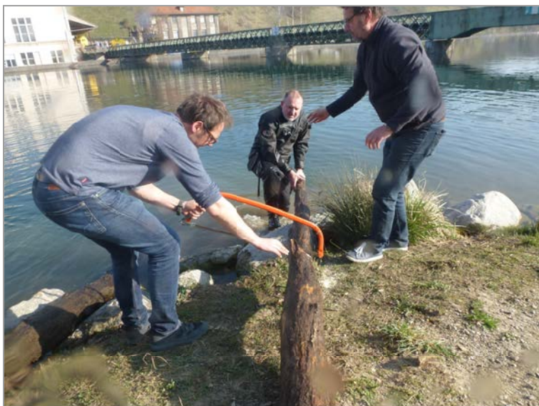
Uferpark Luterbach Entfernen der Baumstämme 2022/03/27
