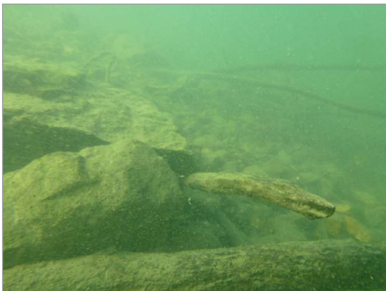
Uferpark Luterbach Entfernen der Baumstämme 2022/03/27
