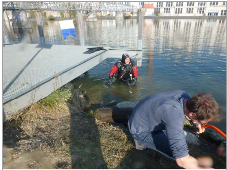
Uferpark Luterbach Entfernen der Baumstämme 2022/03/27
