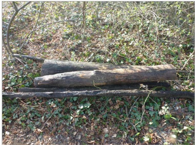
Uferpark Luterbach Entfernen der Baumstämme 2022/03/27
