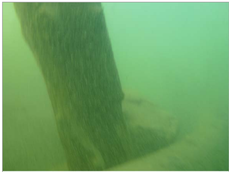
Uferpark Luterbach Entfernen der Baumstämme 2022/03/27
