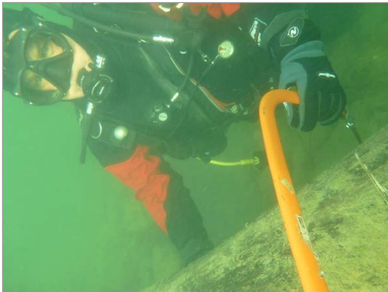
Uferpark Luterbach Entfernen der Baumstämme 2022/03/27
