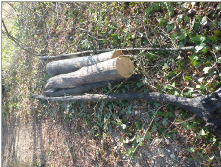
Uferpark Luterbach Entfernen der Baumstämme 2022/03/27
