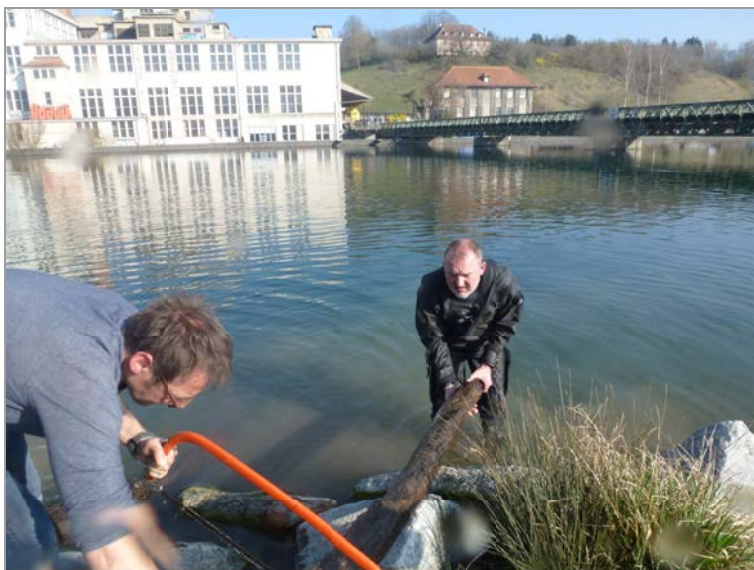
Uferpark Luterbach Entfernen der Baumstämme 2022/03/27
