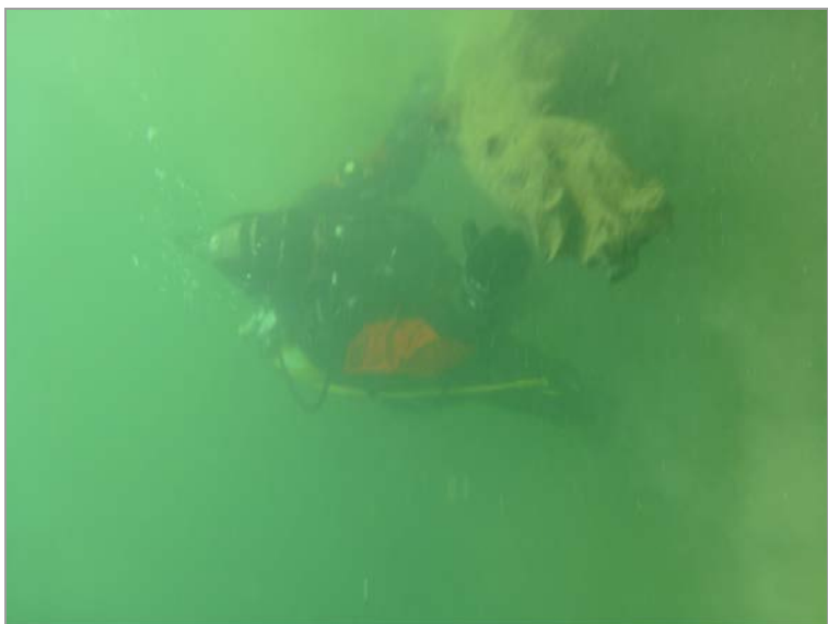
Uferpark Luterbach Entfernen der Baumstämme 2022/03/27
