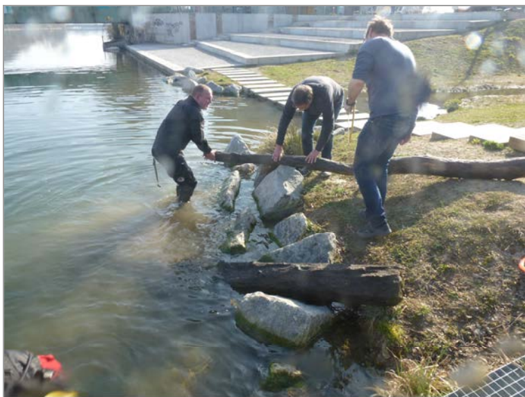
Uferpark Luterbach Entfernen der Baumstämme 2022/03/27
