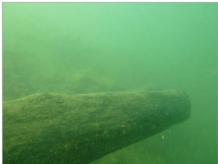
Uferpark Luterbach Entfernen der Baumstämme 2022/03/27
