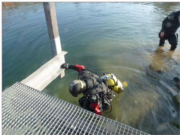
Uferpark Luterbach Entfernen der Baumstämme 2022/03/27
