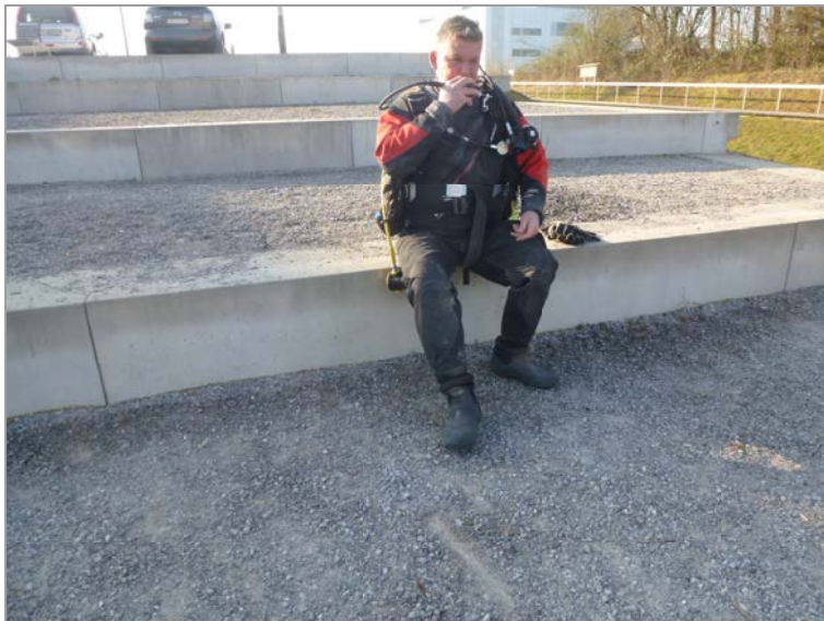
Uferpark Luterbach Entfernen der Baumstämme 2022/03/27
