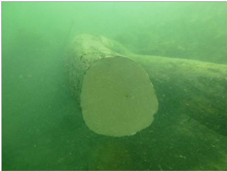
Uferpark Luterbach Entfernen der Baumstämme 2022/03/27
