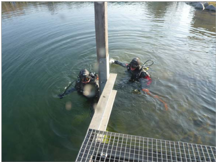
Uferpark Luterbach Entfernen der Baumstämme 2022/03/27
