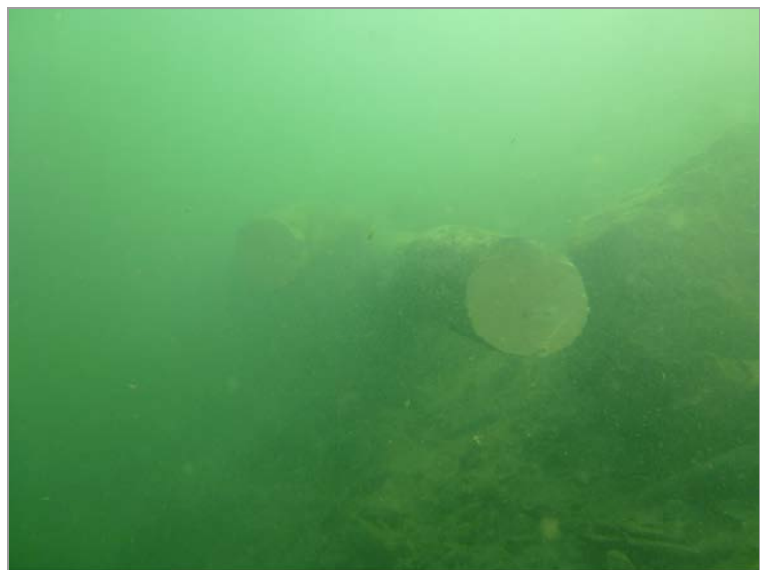
Uferpark Luterbach Entfernen der Baumstämme 2022/03/27
