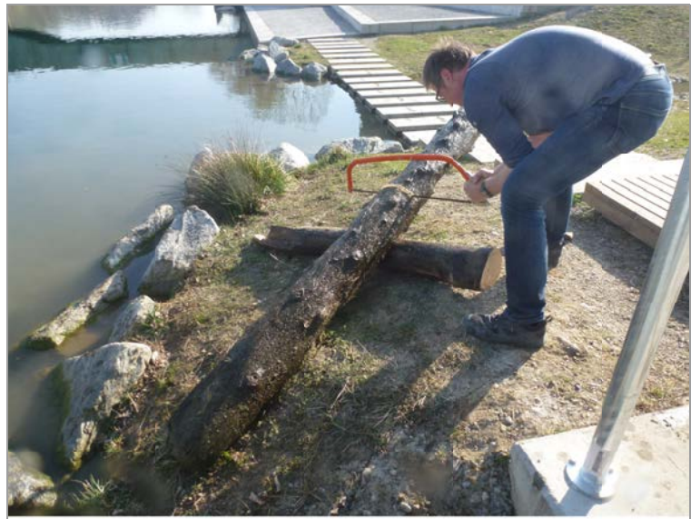
Uferpark Luterbach Entfernen der Baumstämme 2022/03/27
