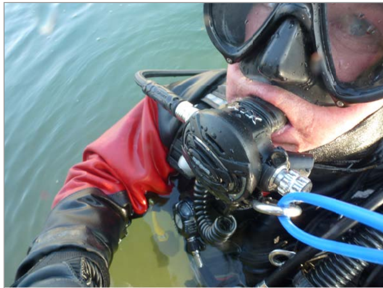
Uferpark Luterbach Entfernen der Baumstämme 2022/03/27
