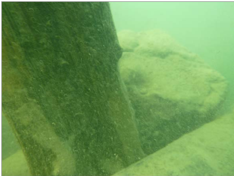
Uferpark Luterbach Entfernen der Baumstämme 2022/03/27
