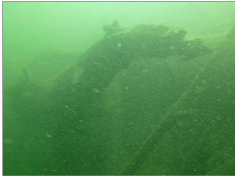
Uferpark Luterbach Entfernen der Baumstämme 2022/03/27
